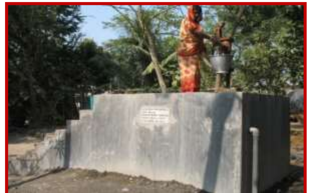
টিউবওয়েল উঁচুতে স্থাপন
